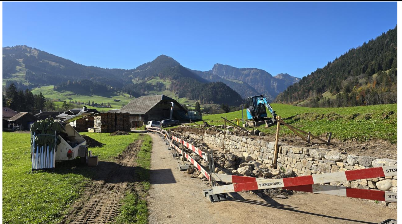
Foto 2: A Château-d'Oex, il muro lungo la Route du Pré, un tratto IVS di importanza nazionale, è stato in gran parte restaurato come muro a secco. (Foto: SL-FP).
