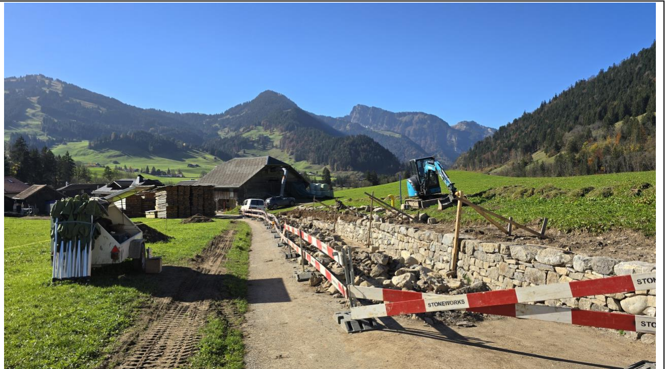
Photo 2: à Château-d'Oex, le mur bordant la route du Pré, tronçon IVS d'importance nationale, a été restauré en grande partie en pierres sèches. (photo: SL-FP)
