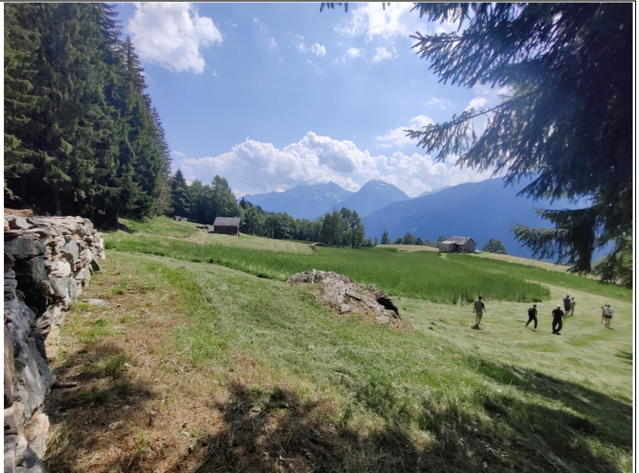
Foto 3: Das Maiensäss Campiroi liegt auf einer sonnigen Terrasse, umsäumt von einer langen Trockenmauer, welche im Rahmen des Projektes saniert wird. (Foto: SL-FP)
