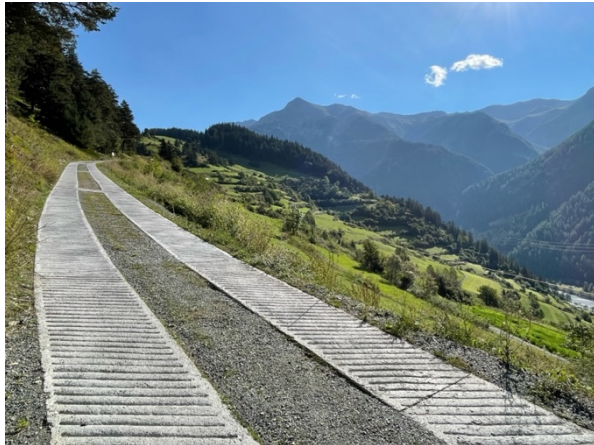
Abbildung 7: Betonspurweg von Ramosch in Richtung Motta hoch (eigene Aufnahme)
