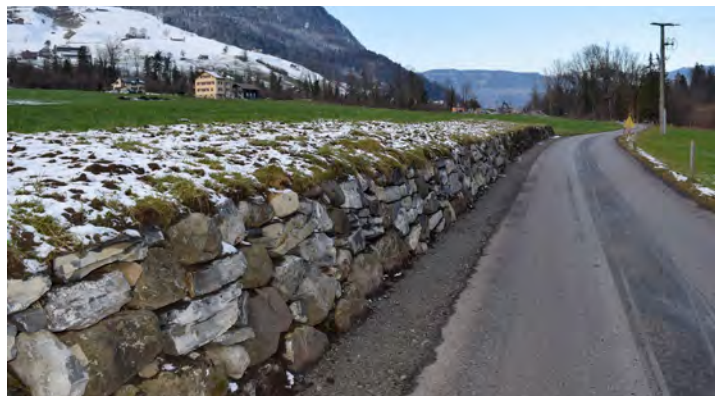
Ein Abschnitt des sanierten Weges in Dallenwil
