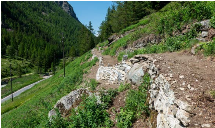
Restaurierte Mauer am historischen Verkehrsweg in Saas-Balen
