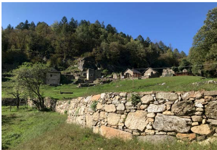
Restaurierte Trockenmauer bei Selvapiana
